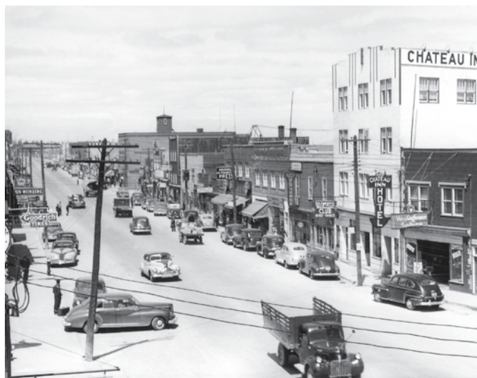
La 3 e Avenue, entre les 7 e et 8 e Rues, en 1950. (Fonds P126-Herby Goyette)
